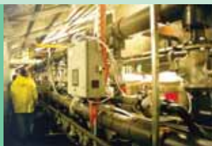
Purificación del agua para cañones de nieve en un estación de esquí en Australia. La agua viene de una represa local.
