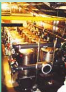
Purificación del agua para cañones de nieve en un estación de esquí en Australia. La agua viene de una represa local.
